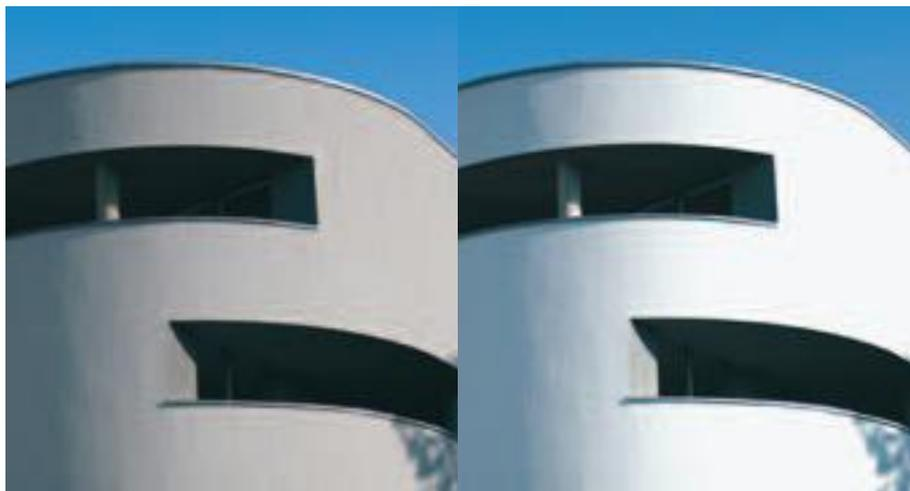
**Проблема традиционно используемых фасадных красок:** С течением времени загрязнения на фасадах становятся все более заметными. Особенно на наиболее подверженных атмосферным воздействиям сторонах. Здесь по причине большой влажности и отложении грязи на поверхности стен, микроорганизмы находят для себя идеальную питательную среду.
